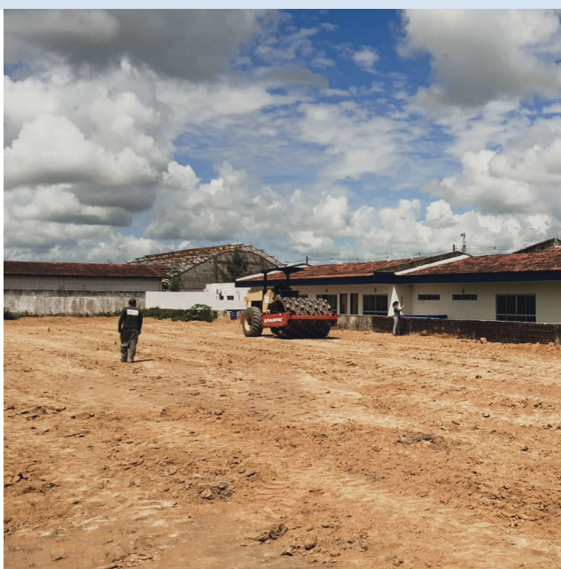
Construção do prédio das Promotorias de Justiça de Atalaia
