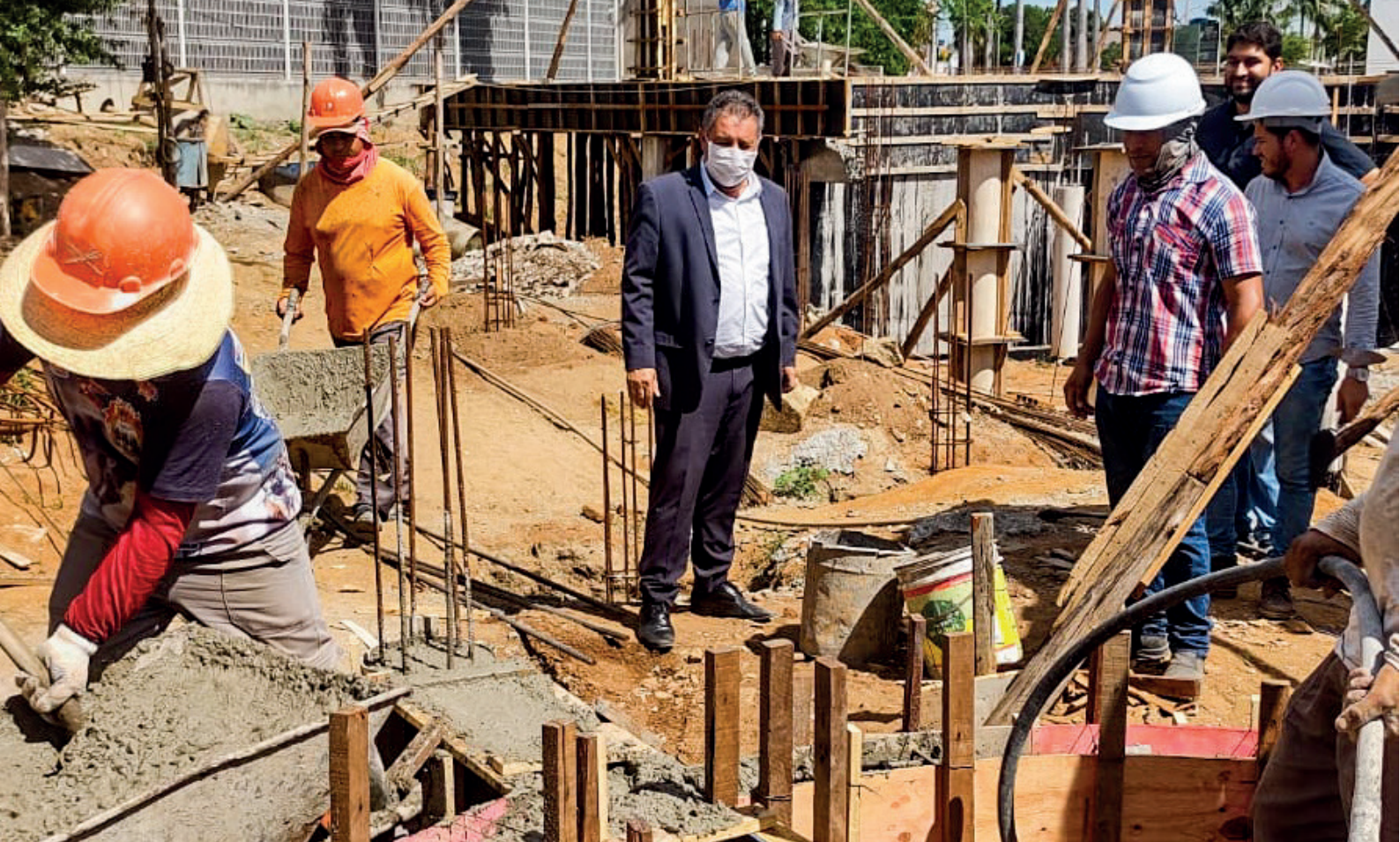
PGJ Márcio Roberto visita a obra da sede das Promotorias em Palmeira dos Índios
